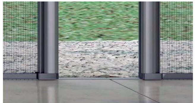
AUSENCIA DE GUIA INFERIOR/ ABSENCE OF LOWER GUIDE/ ABSENCE DE COULISSE INFÉRIEUR
